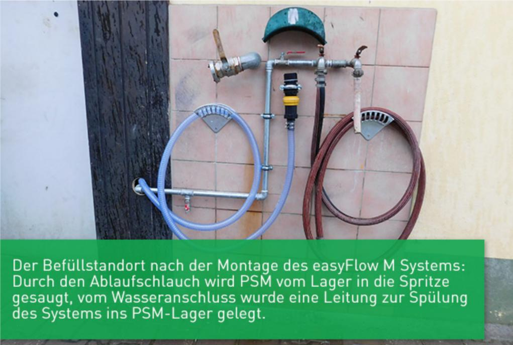
Der Befüllstandort nach der Montage des easyFlow M Systems: Durch den Ablaufschlauch wird PSM vom Lager in die Spritze gesaugt, vom Wasseranschluss wurde eine Leitung zur Spülung des Systems ins PSM-Lager gelegt.
