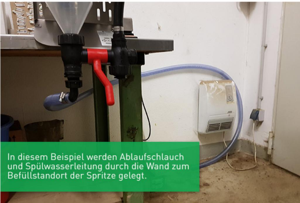
In diesem Beispiel werden Ablaufschlauch und Spülwasserleitung durch die Wand zum Befüllstandort der Spritze gelegt.
