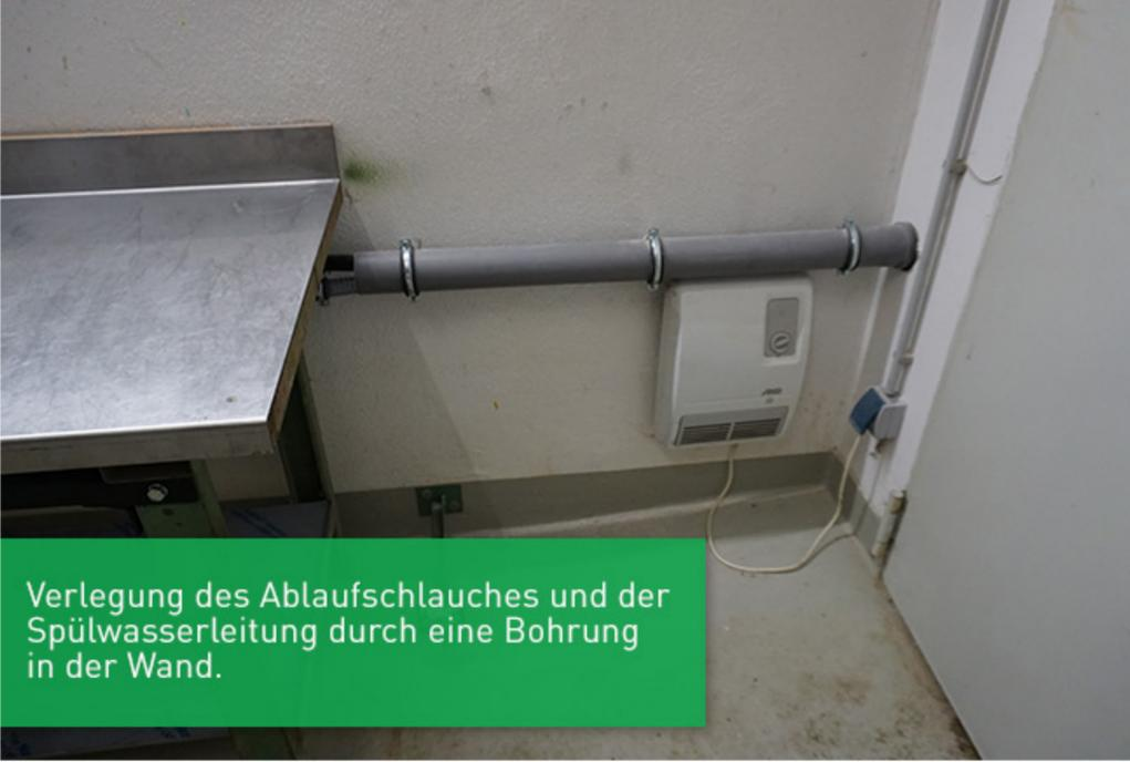
Verlegung des Ablaufschlauches und der Spülwasserleitung durch eine Bohrung in der Wand.
